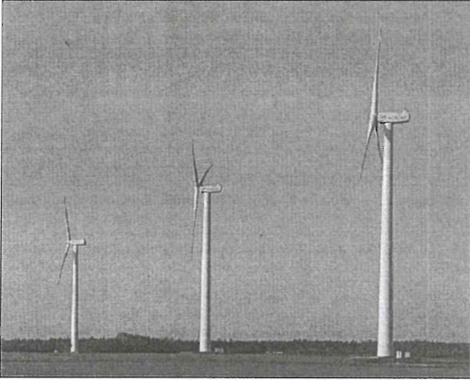
Şekil 3. Rüzgar santralinin görünüşü
